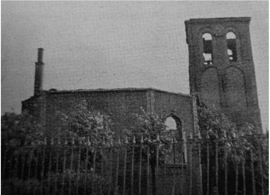
Die ausgebrannte Stadtkirche aus der Sicht der Pastorsgasse
